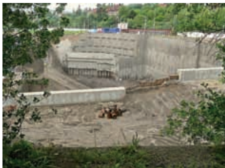
Obr. 3. Praha, Hradčany, pohled na bastion č. XIII. Nešetrný způsob provádění prací související se stavbou tunelu v těsné blízkosti hradby. (Foto Veronika Bartošová, 2009)
