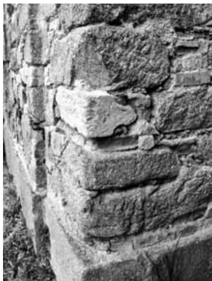
Obr. 9. Skapce (okres Tachov), kostel Nejsvětější Trojice, jihozápadní nároží barokní chrámové lodi, v němž je osazen pískovcový kus gotického klenebního žebra ve tvaru klínu s oboustranným výžlabkem a se zbytky původní polychromie. (Foto Jan Kaigl, 2008)
